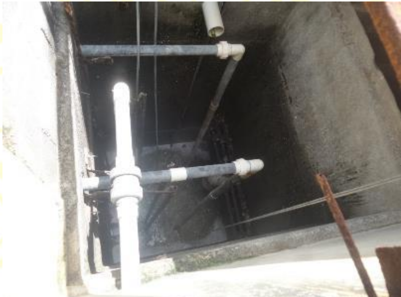
Imagen 8. Cárcamo de bombeo
