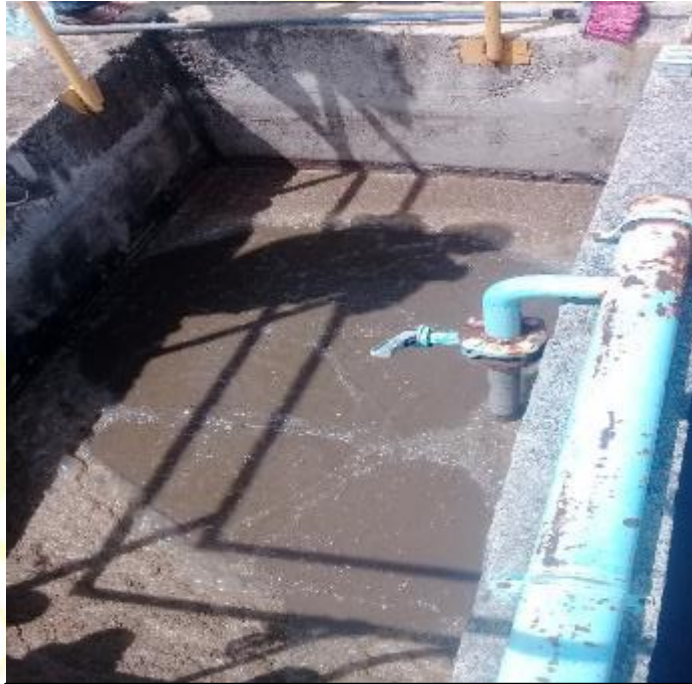
Imagen 10. Tanque de lodos
