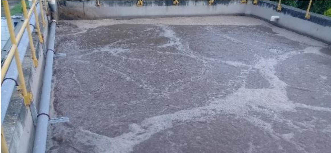
Imagen 9. Reactor aerobio
