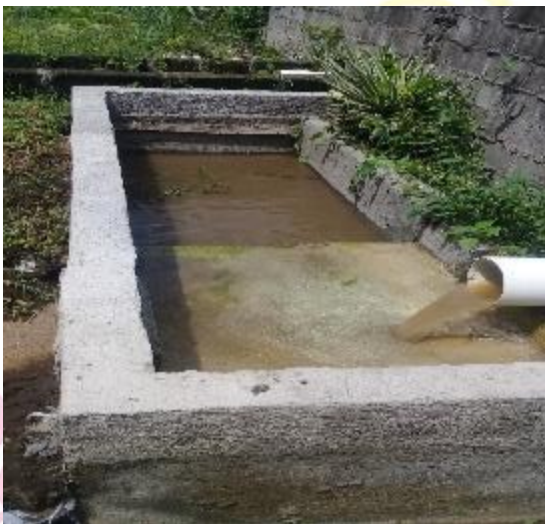
Imágenes 12 y 13. Vertido a cuerpo receptor del agua tratada.
