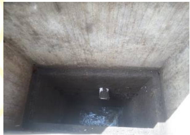
Imagen 5. Tubo de descarga a nivel de seguridad.
