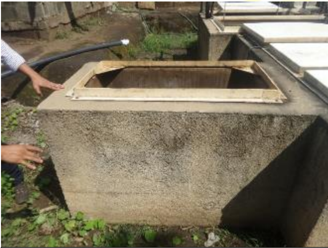
Imagen 4. Entrada de agua servida
