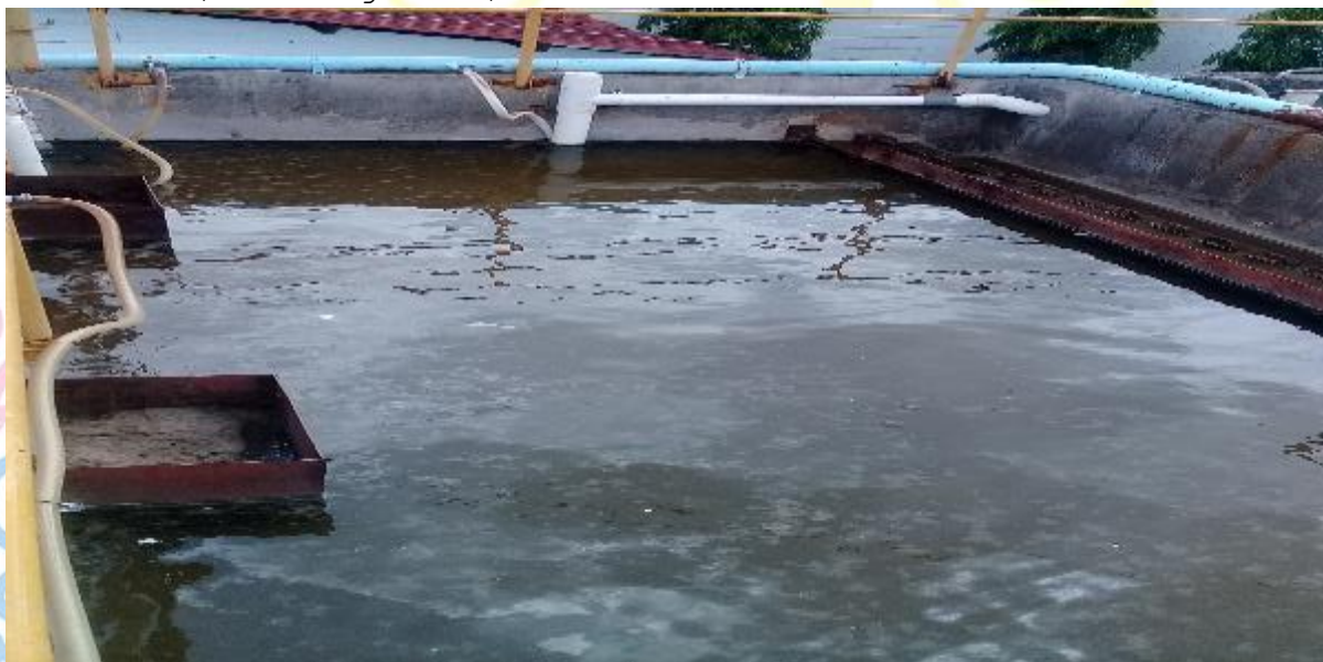
Imagen 11. Sedimentador
