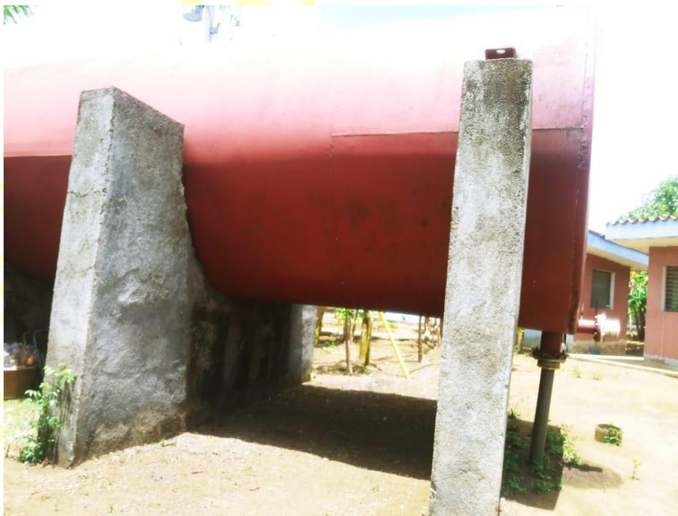
Figura 3 Tanque de almacenamiento para emergencia del SAP
