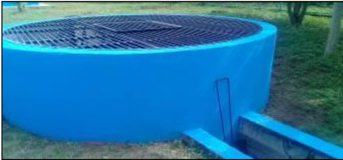
Imagen 4. Estación de bombeo
