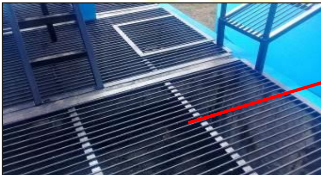
Imagen 9. Tanque de secado de lodos
