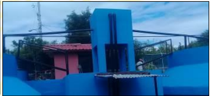
Imagen 5. Tanque distribuidor de caudal
