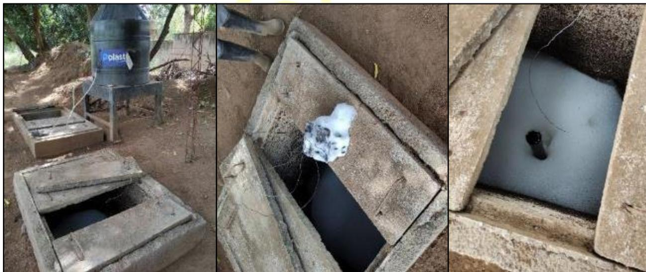
Figura 11 Proceso de desinfección en el STARD en la Urb. El Cortijo de La Sierra
