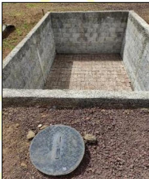
Figura 7 Era de secado vacía durante la inspección
