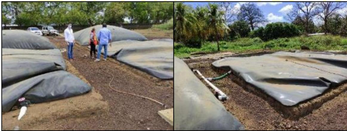
Figura 9 Biodigestores en serie de Geomembrana
