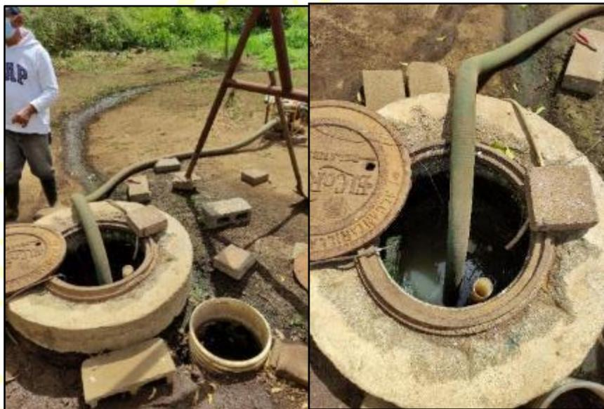
**Figura 6 Pozo de visita utilizado para bombear Aguas Residuales**
