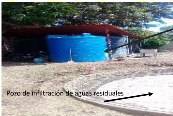
Estación de rebombeo de AP
