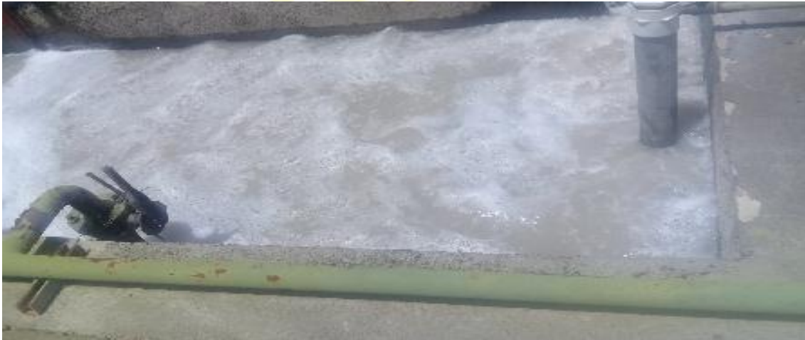
Imagen 2. Tanque de lodos
