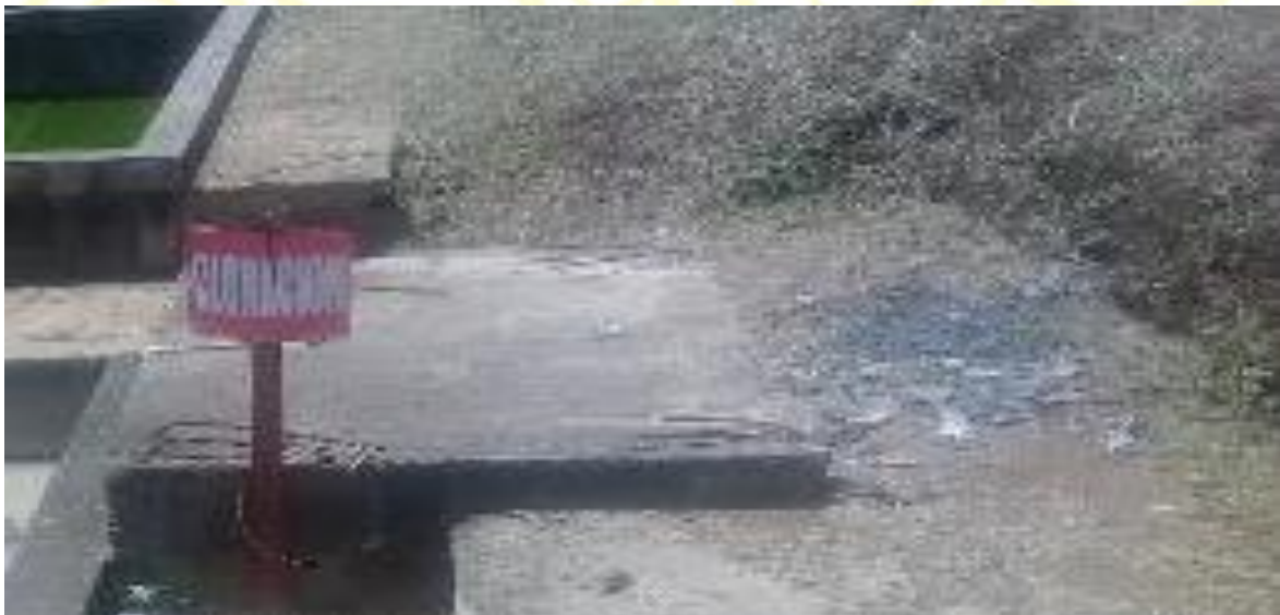
Imagen 4. Unidad de cloración
