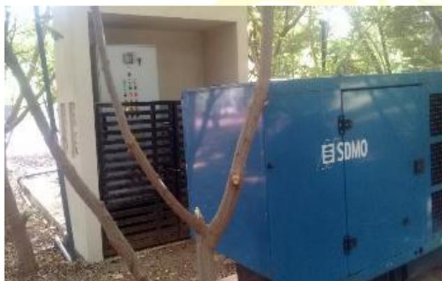
Imagen 1- Generador de electricidad de la Estación de Bombeo Guacalito de la Isla
