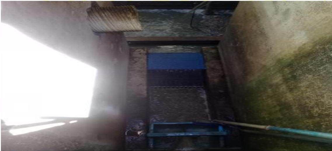
Imagen 1. Rejillas, trampa de grasas y desarenador
