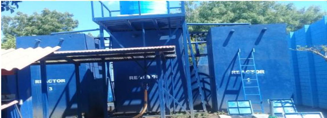
Imagen 3. Reactores anaerobios de flujo ascendente
